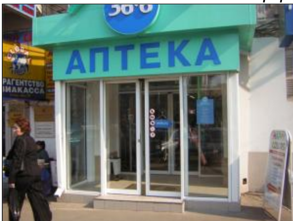
Фото 2 Вход к объекту оценки - отдельный с улицы
