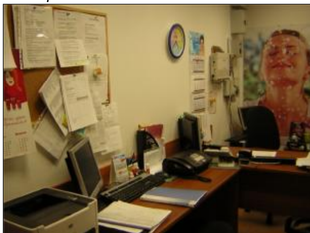
Фото 3 Состояние внутренней отделки офисных помещений
